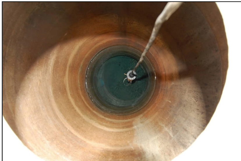
Photo 3: Ancien puits "Schwartz" avec la conduite de départ vers le forage-captage visible en bleu à gauche (avant fermeture définitive du puits avec de l'argile)
