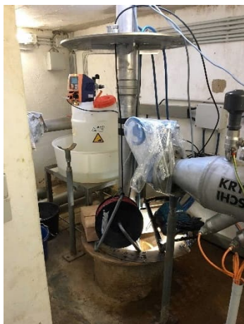
Photo 7: Tête de forage avec la mise en place de la nouvelle pompe et de la colonne d'exhaure et présence à droite de la lampe UV
