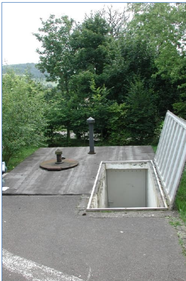
Photo 1: Vue du dessus du regard du forage-captage "Schwartz" avec la création d'un nouvel d'accès sur la droite et un agrandissement du regard
