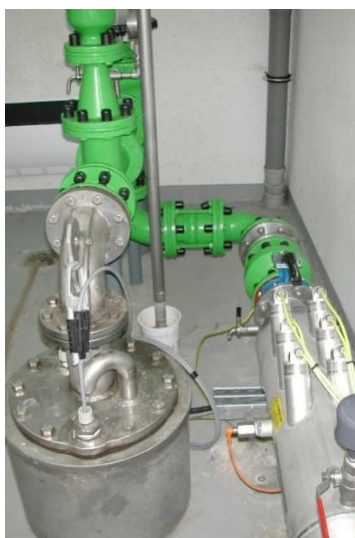
Photo 6: Tête du forage "Kiesel" avec le système de désinfection UV à droite
